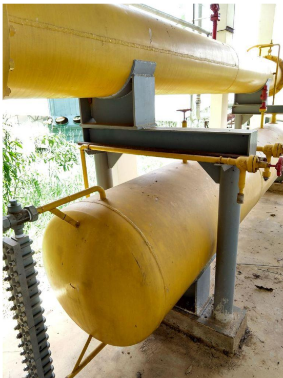
Figura 5 – Reservatório de amônia
