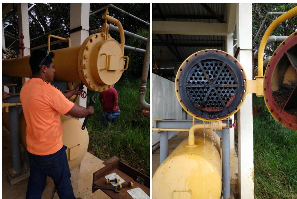
Figura 4 – Avaliação do condensador de amônia
